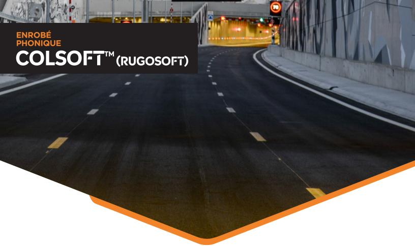
L'enrobé phonique COLSOFT™ est un enrobé pour couche de roulement qui améliore la **sécurité**, le confort des usagers et des riverains. Il assure une **adhérence élevée** permet de **réduire le bruit** des pneus sur la chaussée de façon remarquable et **absorbe** une partie des bruits mécaniques des véhicules.
